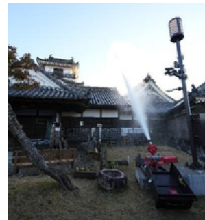
高知城に設置された監視システムと連動した自動放水銃
